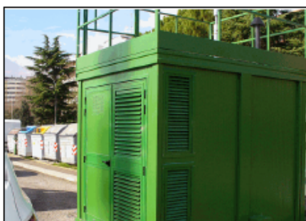
Vista LATERALE DESTRA
